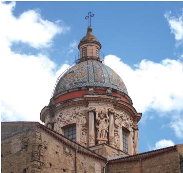
65. Palermo, chiesa del Carmine Maggiore, vista esterna della cupola.
