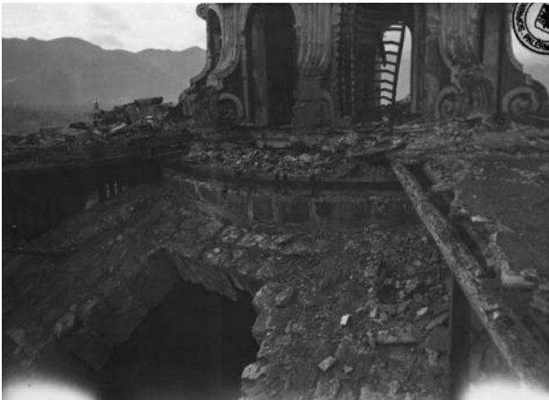
62. Palermo, chiesa del SS. Salvatore, particolare della cupola danneggiata dai bombardamenti (Soprintendenza Beni Culturali e Ambientali di Palermo, su concessione dell'Assessorato per i Beni culturali e l'Identità siciliana della Regione siciliana. Dipartimento regionale dei Beni culturali e l'Identità siciliana).
