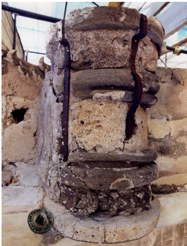
32. Palermo. Chiesa di Santa Caterina, cupola, particolare delle gaffe metalliche a sostegno degli elementi decorativi (Soprintendenza Beni Culturali e Ambientali di Palermo, su concessione dell’Assessorato per i Beni culturali e l’Identità siciliana della Regione siciliana. Dipartimento regionale dei Beni culturali e l’Identità siciliana).
