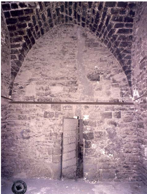
33. Palermo. Chiesa di San Nicolò all’Albergheria, campanile, particolare delle catene (Soprintendenza Beni Culturali e Ambientali di Palermo, su concessione dell’Assessorato per i Beni culturali e l’Identità siciliana della Regione siciliana. Dipartimento regionale dei Beni culturali e l’Identità siciliana).
